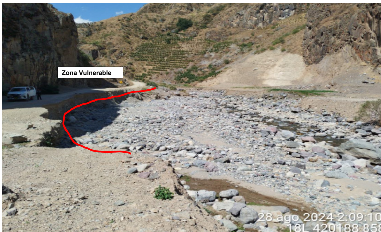
FIGURA N°02: SE OBSERVA LA MARGEN DERECHA DEL RIO EL CUAL ES VULNERABLE ANTE UNA CREDIDA, POR DICHO LADO SE ENCUENTRA COMPLETAMENTE EROSIONADA.
