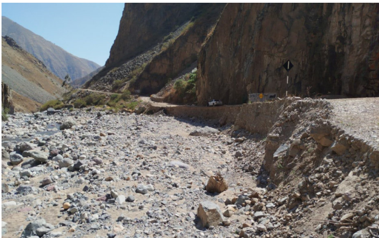
FIGURA N°03: SE OBSERVA LA MARGEN DERECHA DEL RIO, DONDE EN UNA CREDIDA AFECTARIA LA CARRETERA
